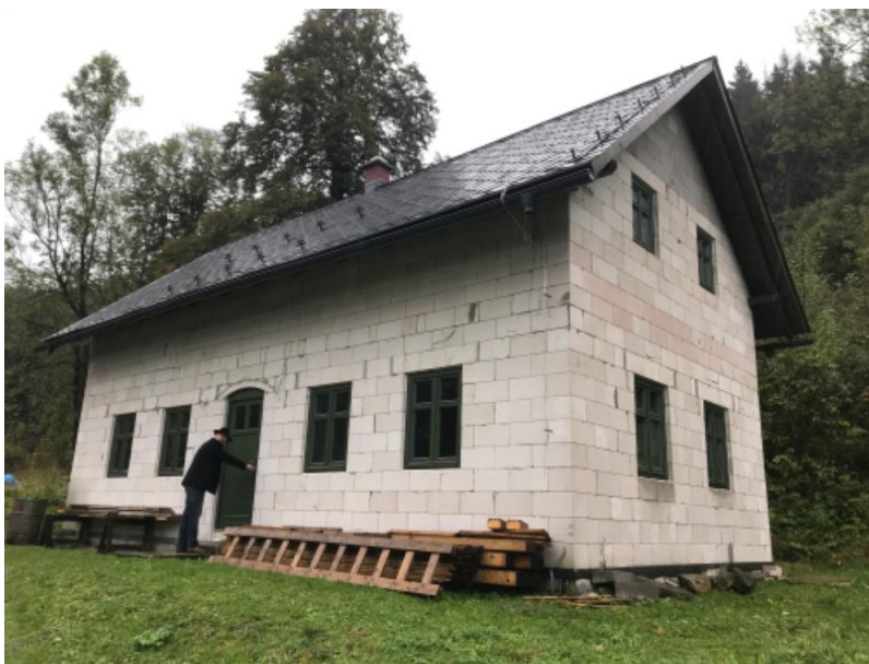
Obr.: Stav Kutzerova domu v Horním Údolí u Zlatých Hor po osazení oken a dveří
